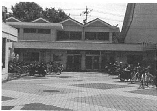
▲第一、第二体育館入口
