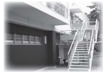
改修工事後の北部厚生会館↑外装が少し変わっています。
