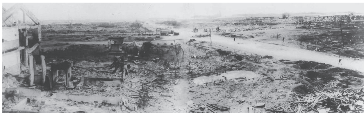
空襲後の豊川海軍工廠（正門付近）
