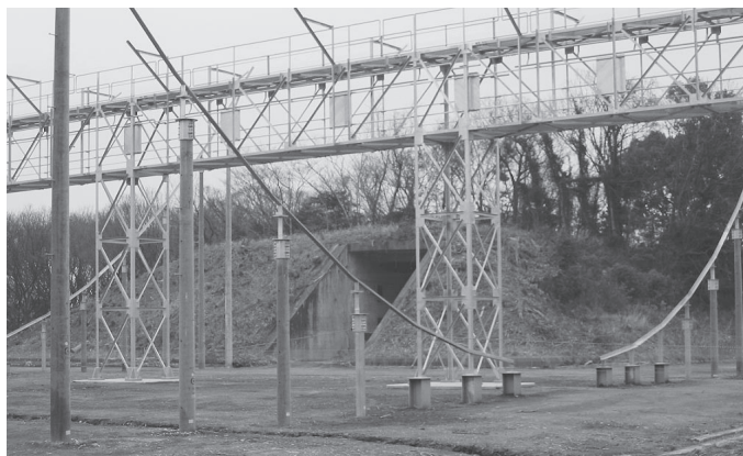
弾薬庫横に新設された太陽風観測アンテナ
