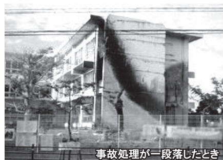
事故処理が一段落したとき
