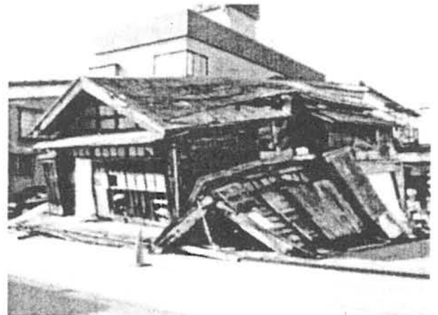
図2 神戸と新潟の古い木造住宅の被害(どちらも2階建ての1階が完全に倒壊している)
