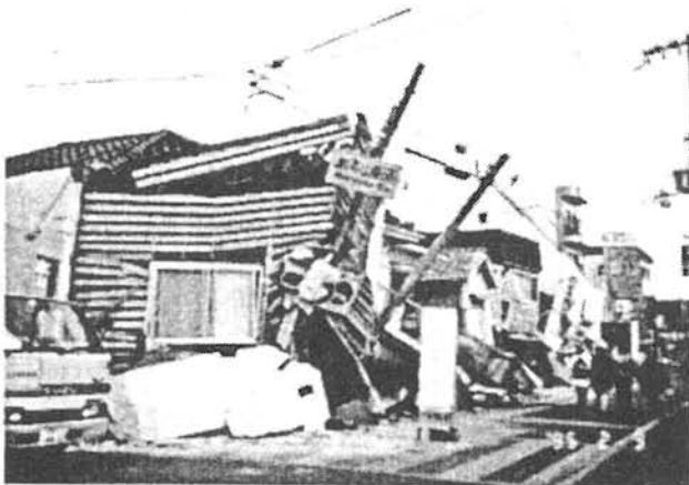
図2 神戸と新潟の古い木造住宅の被害(どちらも2階建ての1階が完全に倒壊している)
